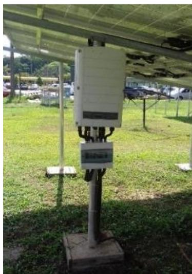
Figura 4 – Inversor e quadro de disjuntores.
