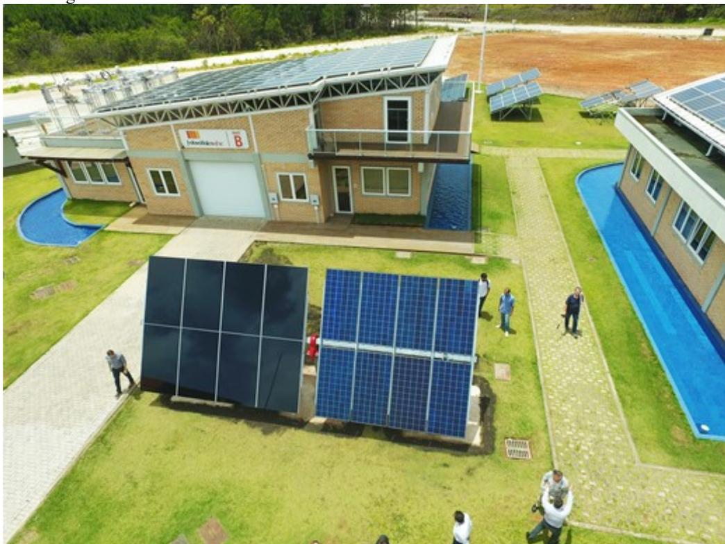
Figura 7 – Seguidor solar de um eixo, sendo que o sistema da direita é composto por módulos de silício cristalino, que foram utilizados para o experimento.
