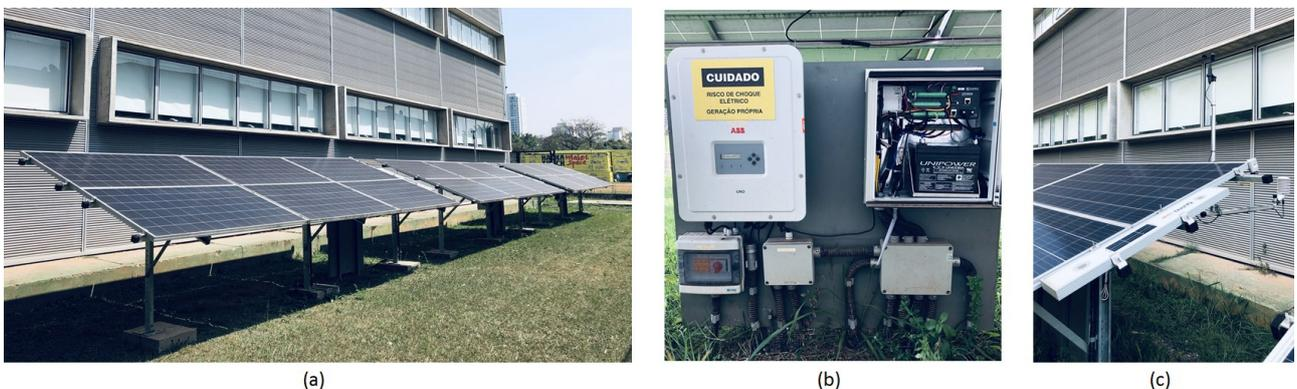
Figura 2 – (a) SFE de 5,85 kWp, (b) Sistema de aquisição de dados e equipamentos, (c) Sensores e instrumentos (Irradiação, sujidade, temperatura do ar, umidade do ar e velocidade do vento).
