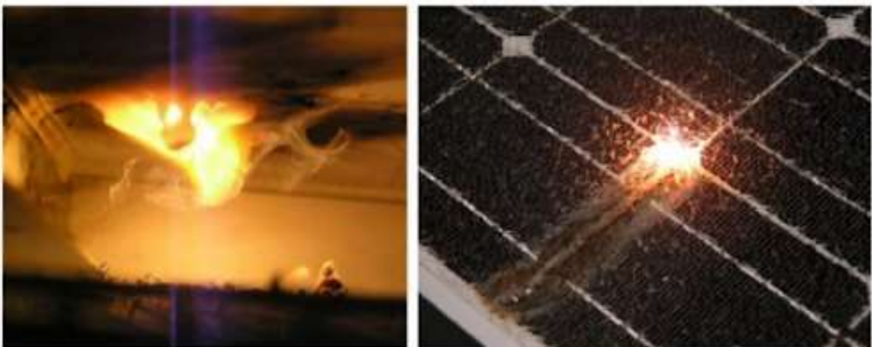
Figura 4 – Arco elétrico em série interno no módulo FV (fonte TÜV Rheinland)
