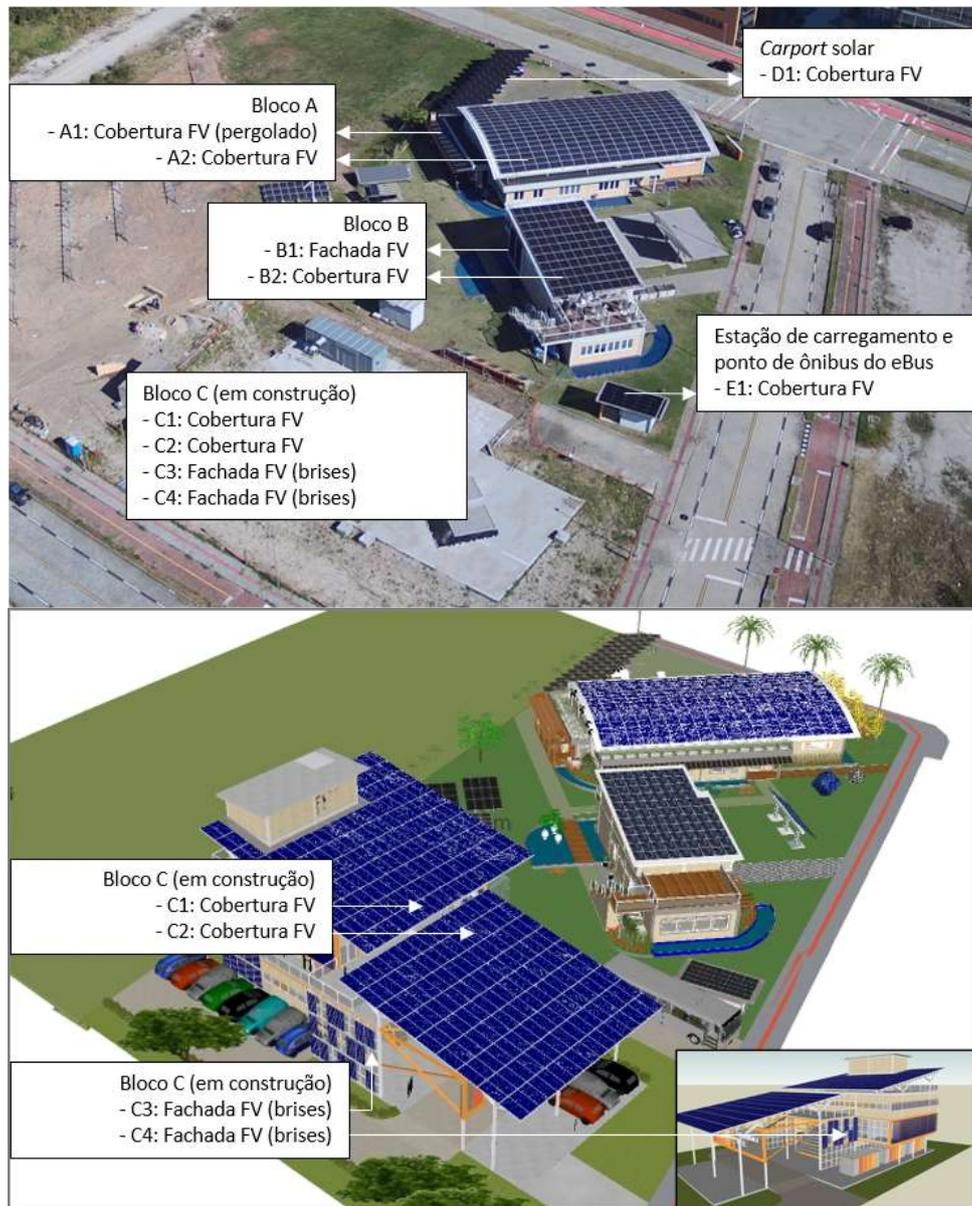
Figura 1 – Figura superior (a) sistemas FV integrados ao Laboratório Fotovoltaica/UFSC; e figura inferior (b) duas vistas do modelo 3D do laboratório, incluindo os sistemas FV integrados ao bloco C, que está em construção.
