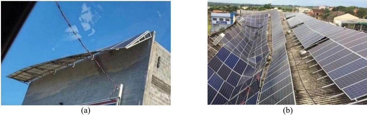
Figura 2 – (a) Falha de um suporte lateral de sistema fotovoltaico e (b) falha da estrutura de sustentação do telhado devido à carga adicional gerada pelos módulos.
