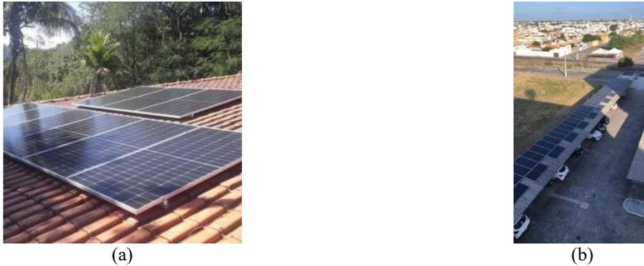
Figura 12 – Sombra (a) de árvores e (b) de um prédio sobre o sistema fotovoltaico.
