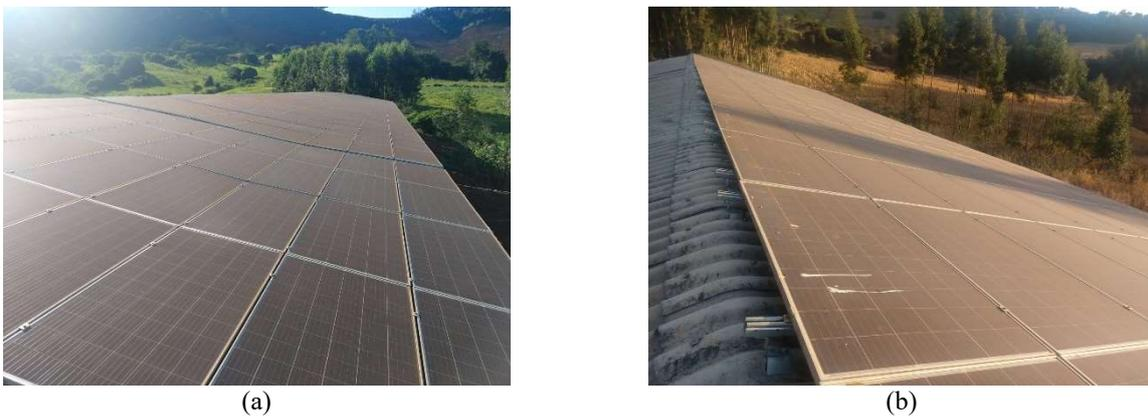
Figura 13 – Sujeira causada por (a) poeira e (b) fezes de animais em dois sistemas fotovoltaicos.
