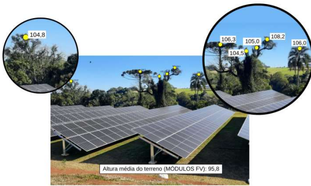
Figura 1- Identificação da altura das árvores em relação ao nível do terreno onde os módulos estão instalados – lateral oeste da UFV.
