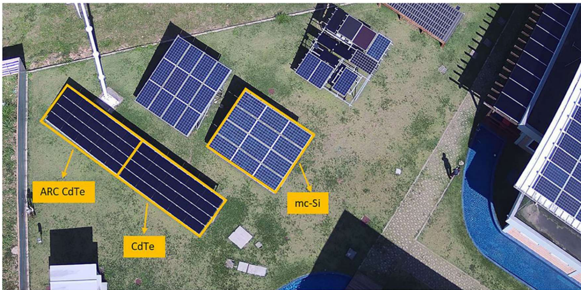
Figura 2 – Vista aérea dos sistemas fotovoltaicos– FOTVOLTAICA UFSC (Pires, 2021)
