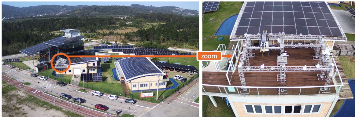
Figura 3 – Imagens áreas do Laboratório e da estação solarimétrica do Fotovoltaica/UFSC.
